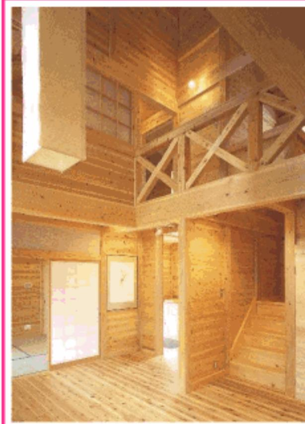
今日の木造住宅構法で最大の問題は壁であり、伝統の土壁に替わる日本にふさわしい壁の開発が、現代日本の民家誕生の鍵といえる。日本の壁は、板壁から土壁へと変遷し、いま再び板壁の時代をむかえる状況にある。「現代の木造住宅論」より抜粋 著者 安藤邦廣さん
