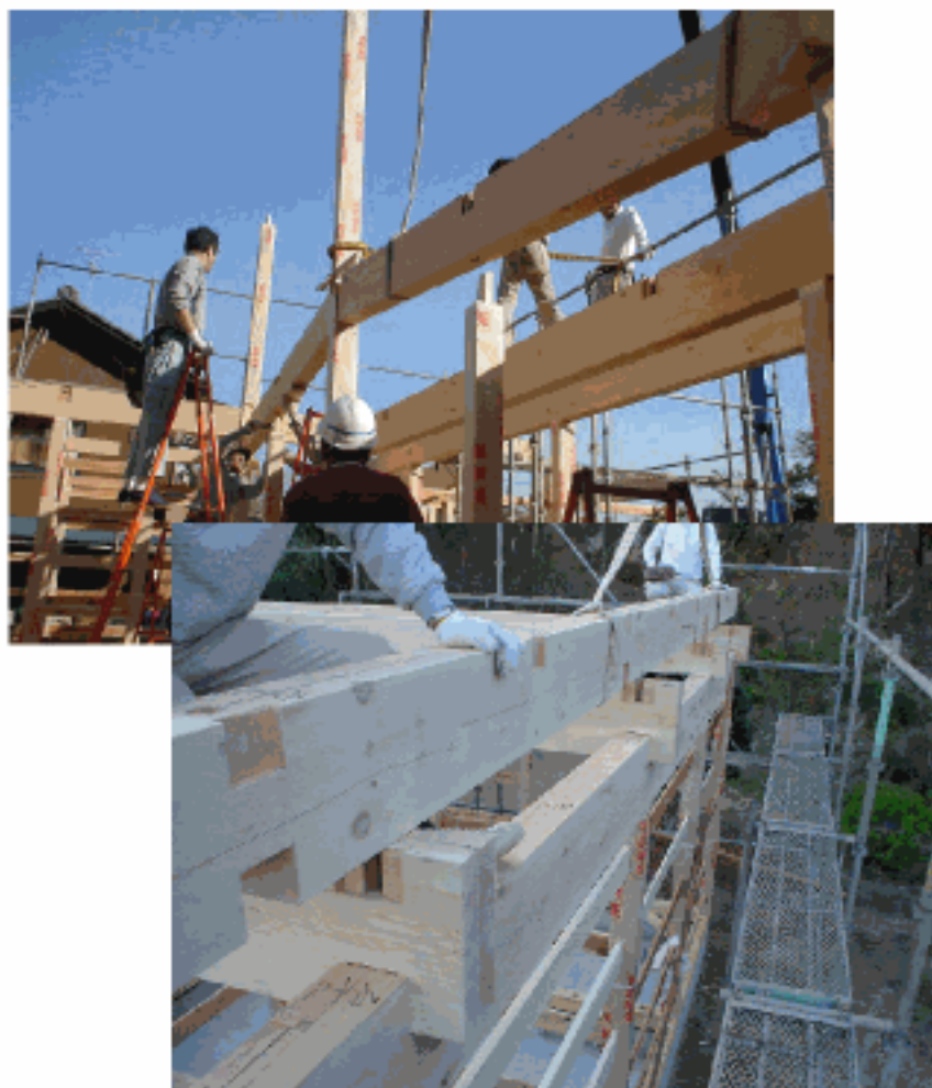
伝統工法の極めつけ、渡りあごの仕口
