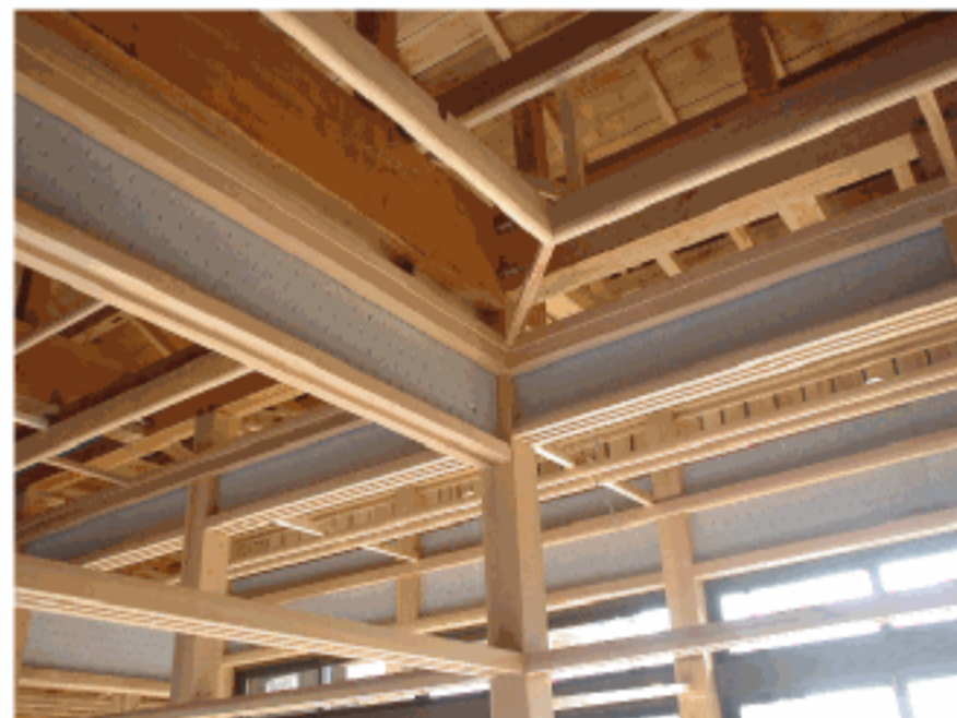
川島邸は杉材を使用した伝統的な天井です。骨組みだけではわかりにくいですが・・・
