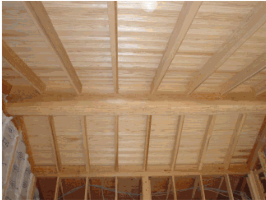
小林邸の天井は杉板張りの勾配天井です。
