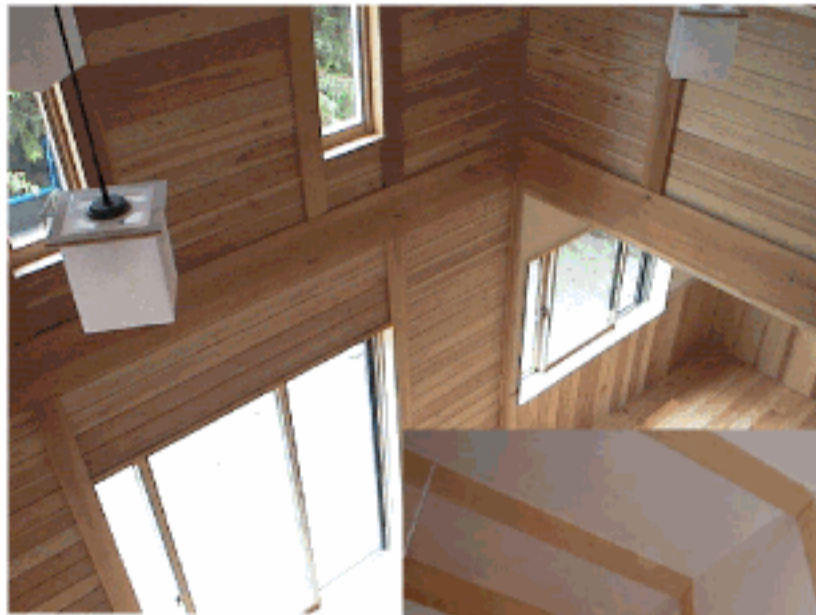
杉の無垢材による壁 (上) 木造軸組みと漆喰壁 (下)
