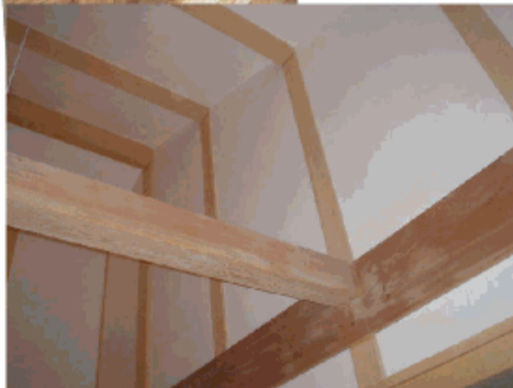
杉の無垢材による壁 (上) 木造軸組みと漆喰壁 (下)
