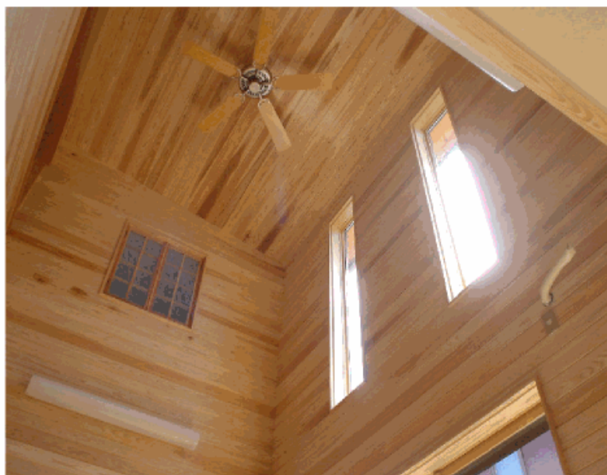
吹き抜け空間を下から見上げたところ
