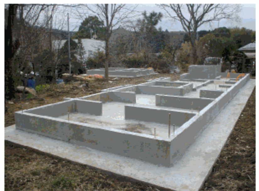
しばらく放置した後、型枠を剥して完成です。アンカーボルトなどは、立ち上がりをつつ前にセットしておきます。
