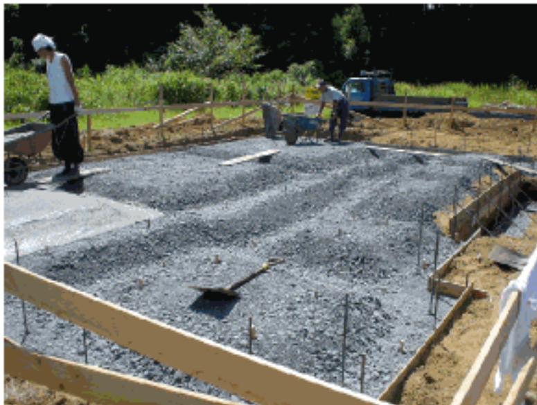
地盤を掘削し、砕石を敷きます。上に湿気が上がらないように、シートをかけて捨てコンを打ちます。
