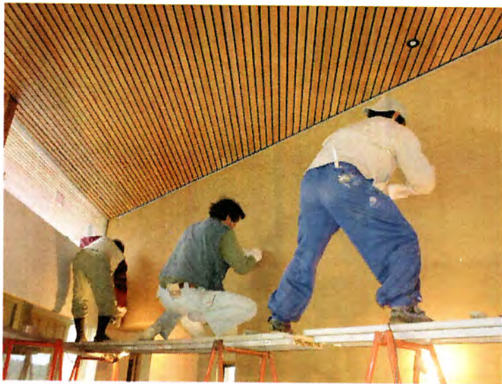
大きな壁・珪藻土をブラシで掻き落とし櫛目をつけているところ
