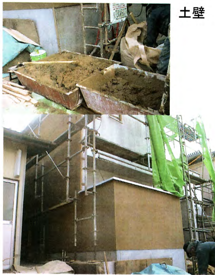
上の写真は土壁材をこねたところと塗ったところ。下は塗りこんだ土壁です。これは上は泉幸甫さんが開発した土壁です。下の写真は3年後のもの。その風合いが素晴らしいです。
