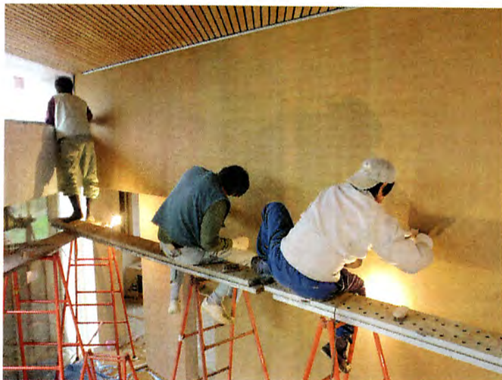
大きな壁・珪藻土をブラシで掻き落とし櫛目をつけているところ
