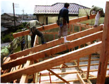
建て方作業 登梁
