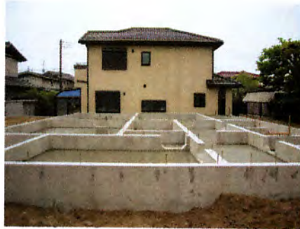
完成した基礎
