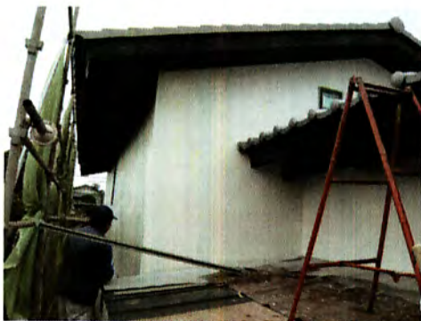
外壁・漆喰塗り作業
