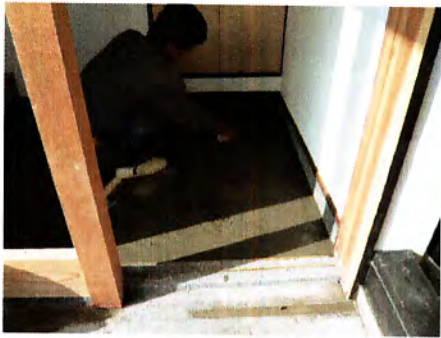
(玄関) 玉石をモルタルで埋め込む
