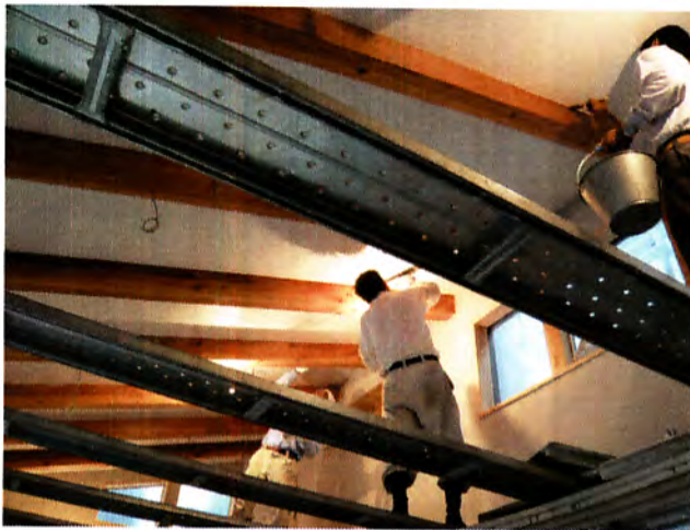
天井に漆喰を塗っているところ
