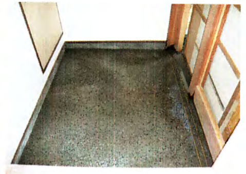
洗い出し仕上げの完成
