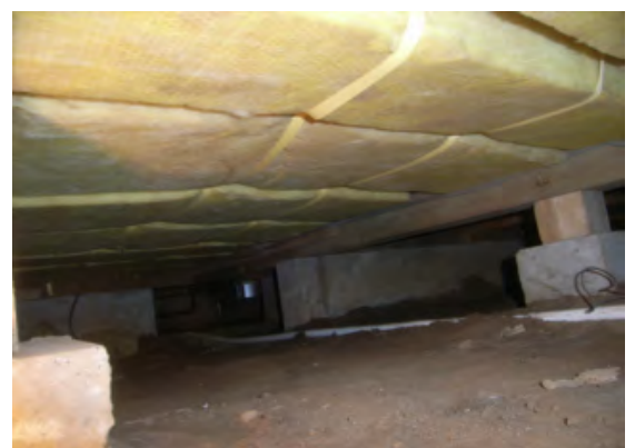
床下の断熱がとても大切です
