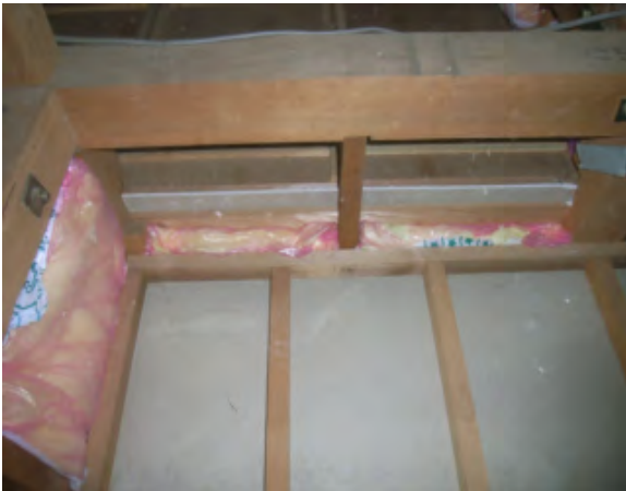
通気止めをする
