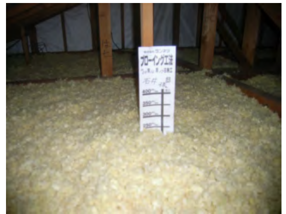
天井・細かい断熱材を噴いていく
