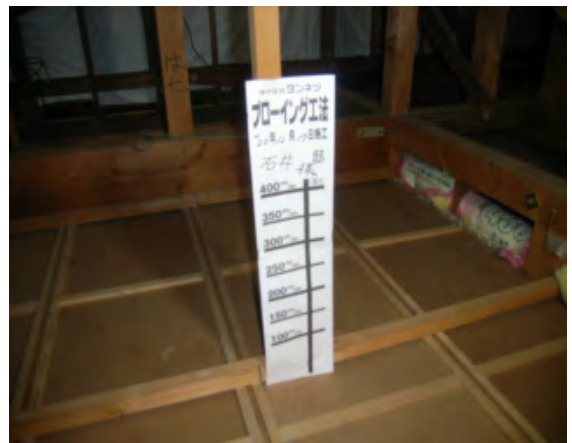
ブローイングする前・断熱材なし
