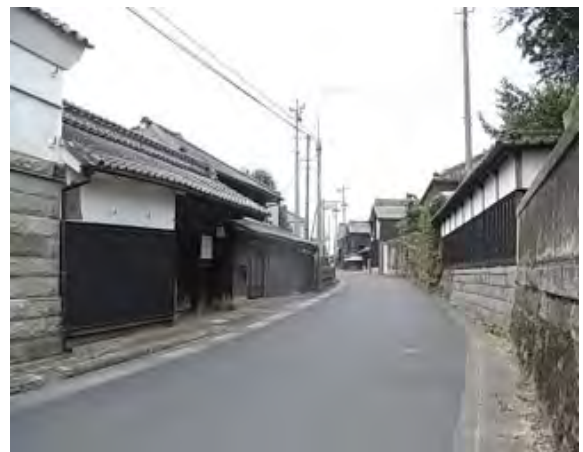
真壁(茨城県) 谷口家住宅の塀
