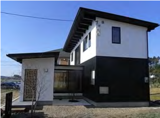
建物全景・東より見る
