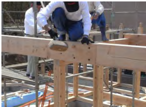
大柱を打ち込んでいるところ
