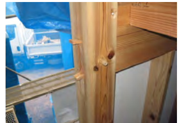
居胴差と通柱 込栓・楔
