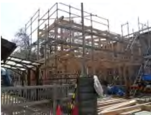
上棟作業も完了
