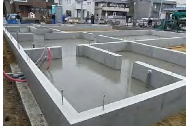
2.基礎が完成しました
