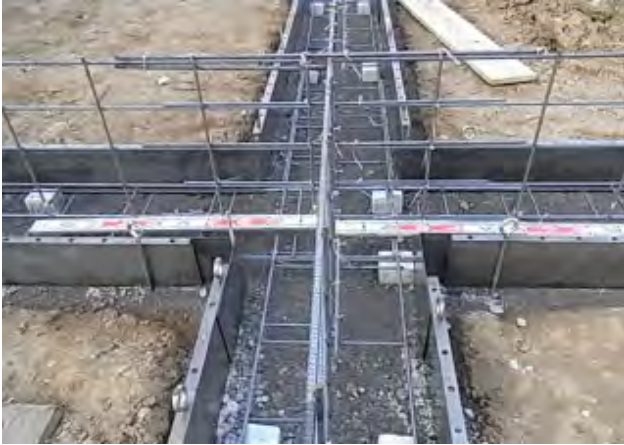
1.基礎 配筋の状況
