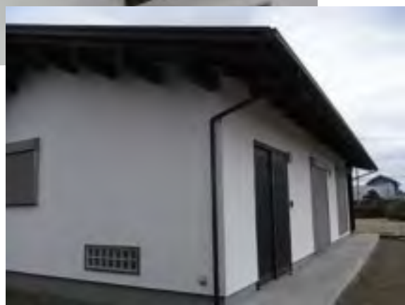
上・仕上がった外壁 漆喰塗りです。 使用材料は田川 産業の古代漆喰
