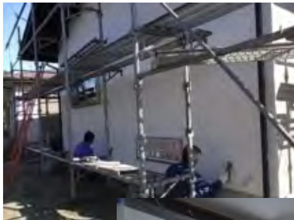
外壁 漆喰を塗る
